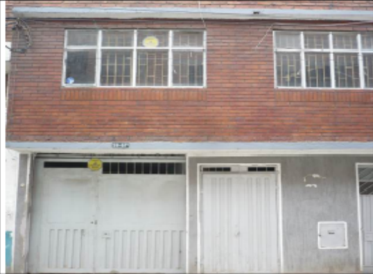
Foto No. 1 Fachada del establecimiento
